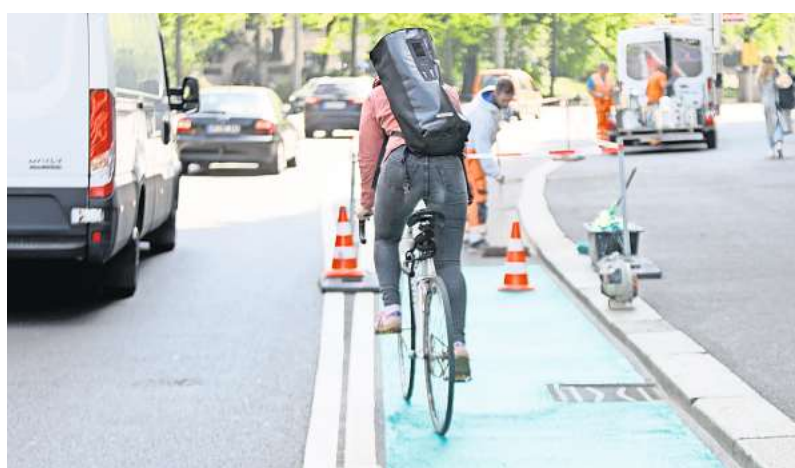
„Verkehrsrgrün“ am Dittrichring: Die Markierungsarbeiten für die neuen Radspuren haben am Donnerstag begonnen. FOTO: ANDRÉ KEMPNER
